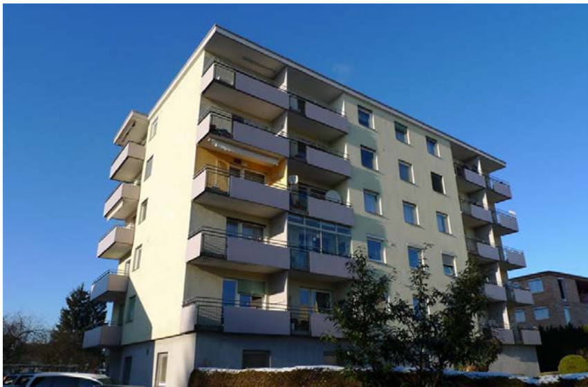
Obrázok: Obytný dom Bahnhofstr. 43, 6890 Lustenau s ETICS s použitím EPS (rok výstavby 1966)
