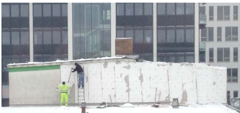
Fotos: Dekonštrukcia ETICS
