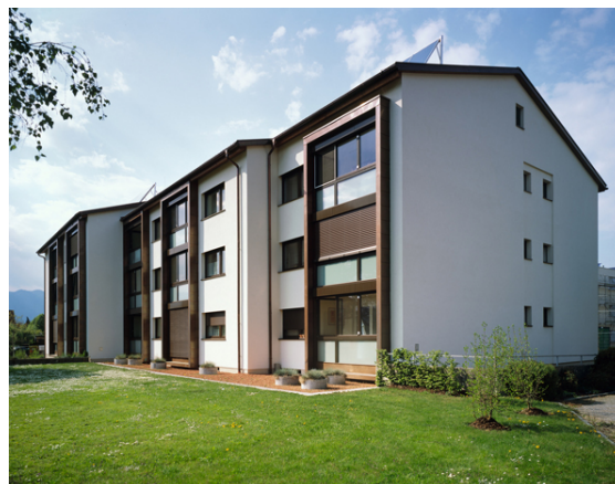
Obrázok: Obytný dom Rankweil-Schleipfweg po obnove
