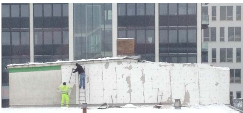
Fotos: Dekonštrukcia ETICS
